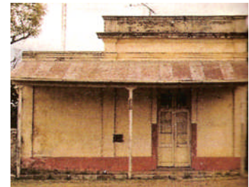
Figura 4. Antigua casa para obreros de la Fábrica Colón 6 .
