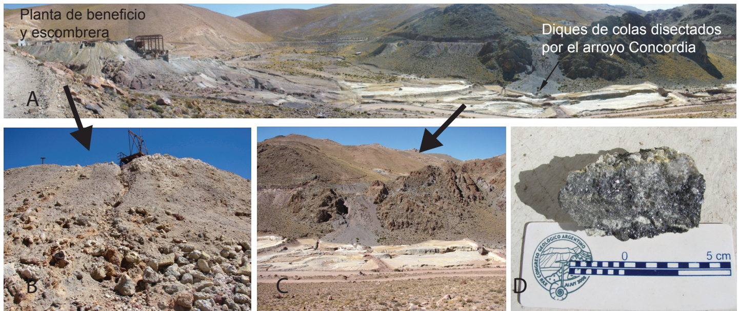
Figura 6. A. Vista panorámica de la mina abandonada Concordia, provincia de Salta, se observa que el arroyo Concordia atraviesa los diques de colas. B. Escombrera, compuesta por fragmentos de roca de diferente tamaño. C. Diques de cola disectados por el arroyo Concordia. Fotos: Marcelo Amosio. D. Muestra de mineral de mena de plomo (galena PbS) que se extraía de las vetas de la mina. Foto: Natalia Salado Paz.
